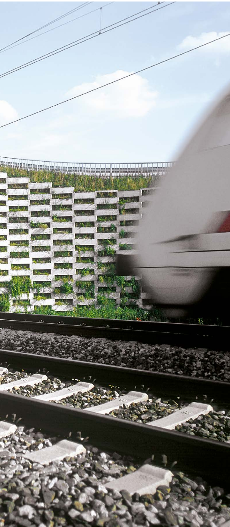
Stützkörper aus luftseitigen Betonfertigteilen, erdseitigen Geogittern oder Betonelementen
