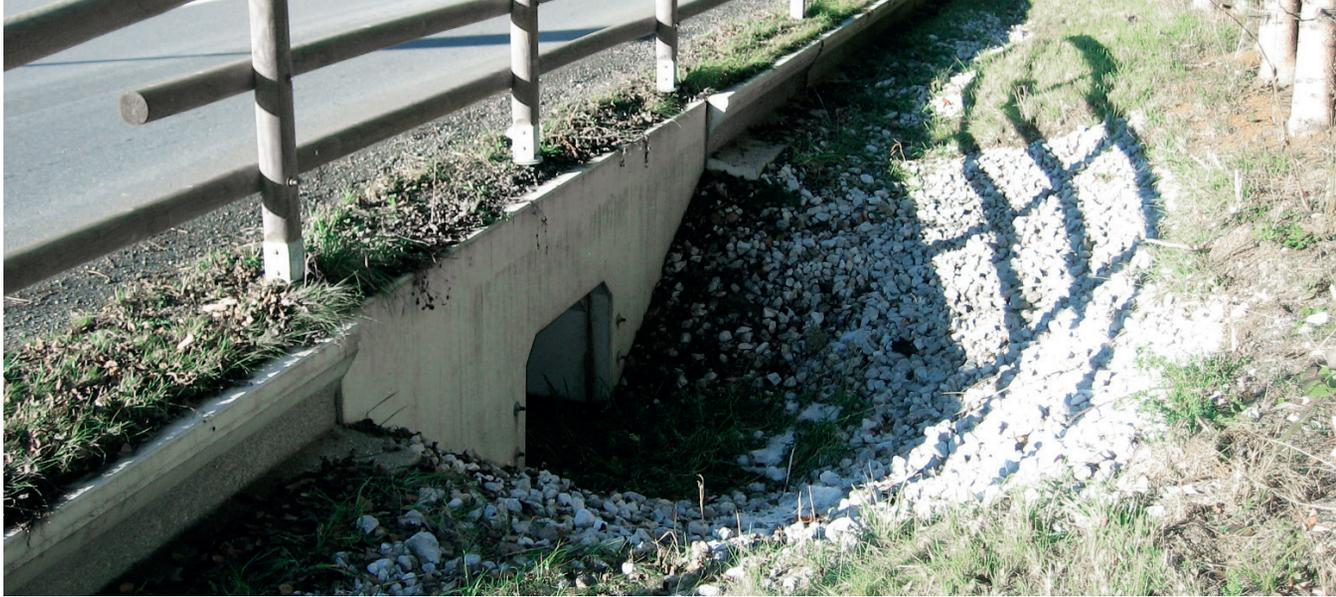
Die Tunnelleitanlage hält wandernde Kleintiere wie Amphibien, Reptilien oder Kleinsäuger von einer Überquerung der Straße auf der Fahrbahn ab. Dank der „Unterführung“ aus Beton ist ein gefahrloses Queren der Straße möglich und ein permanenter Schutz auch bei Jungtier- und Herbstwanderungen das ganze Jahr gewährleistet. Optional kann mit dem integrierten Gitterrost für die Herstellung von landwirtschaftlichen Zufahrtswegen jederzeit und für die Tiere unauffällig unterbrochen werden.
