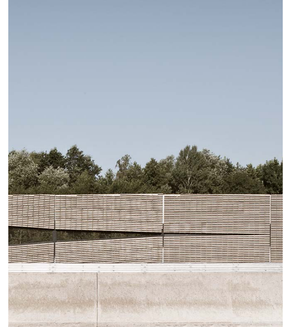
Landscape mit Hohlwelle A8 Innkreis Autobahn Antiesenhofen, AT.
