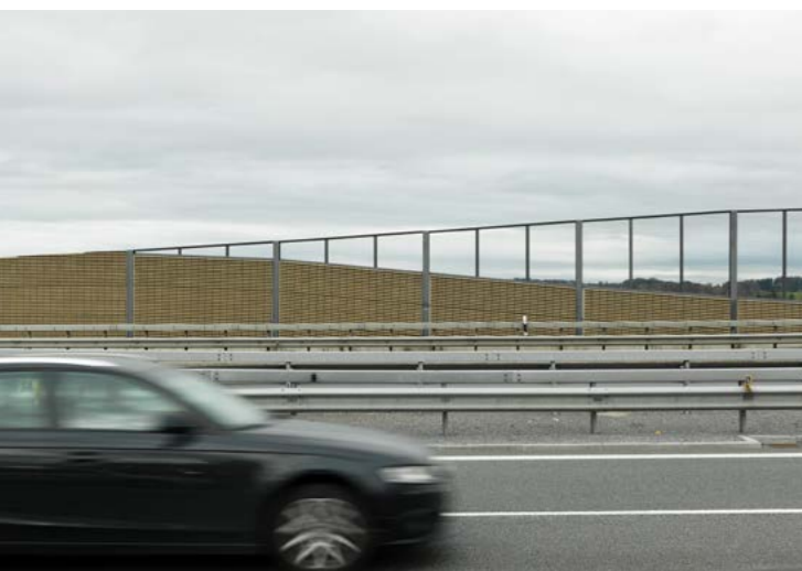
Landscape mit Fensterlösung, A8 Autobahn Bergen, DE.
