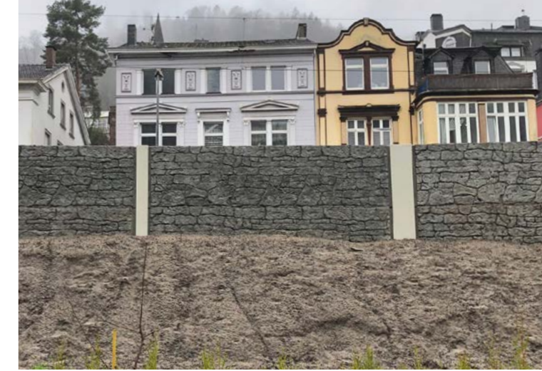
Rückseitenverkleidung, Bahnhof Altona, DE.
