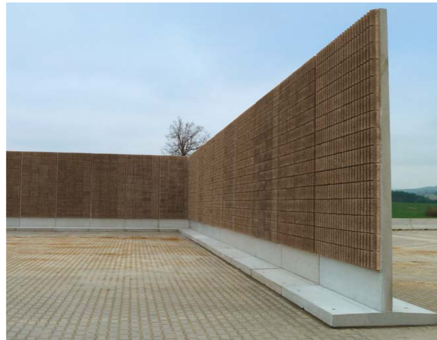
Verkleidung von Betonelementen.
