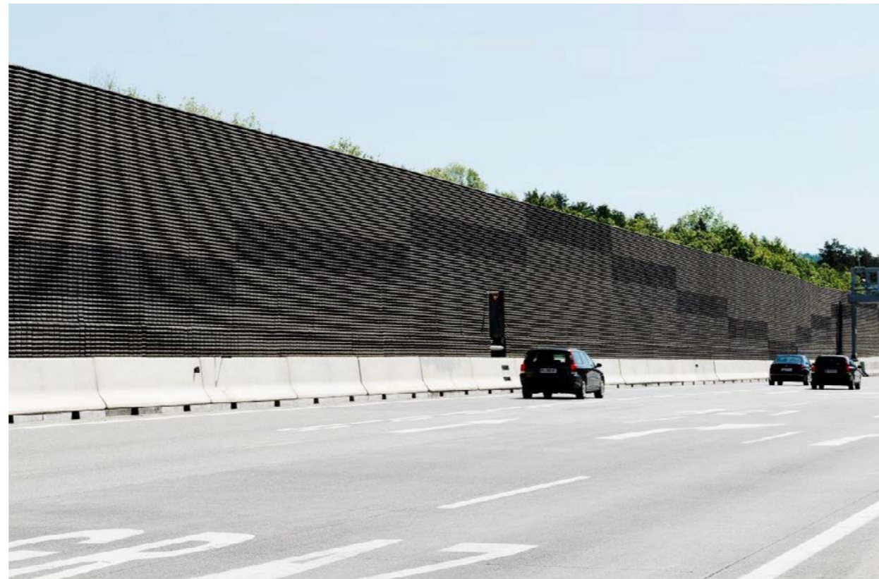
Gerade Wand mit Hohlwelle, A1 West Autobahn Steinhäusl, AT.
