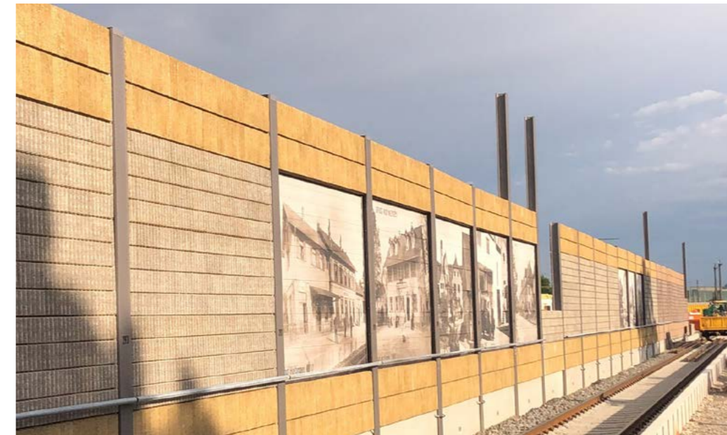
Rückseitengestaltung, Bahnhof Haltingen, DE.
