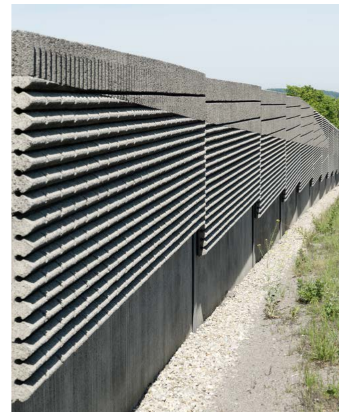
Gerade Wand mit Hohlwelle, A1 West Autobahn Steinhäusl, AT.
