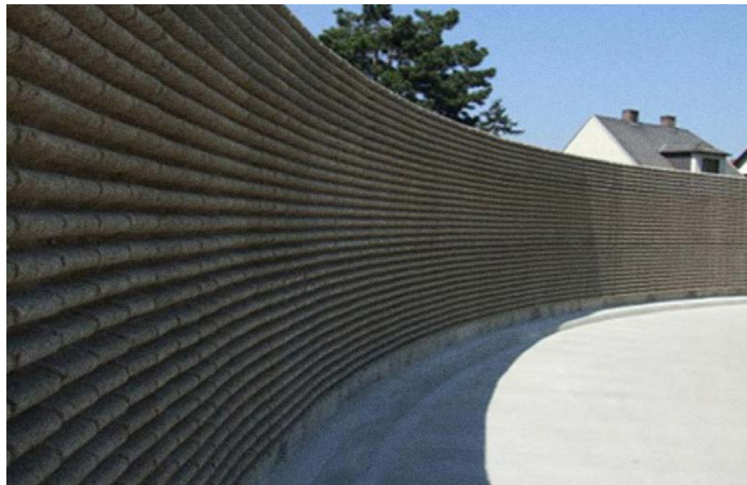
Verkleidung einer gewölbten Wand mit Leube Faseton® Elementen.
