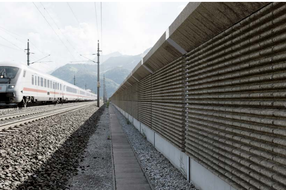
Aufsatzelemente im Gleisbereich.
