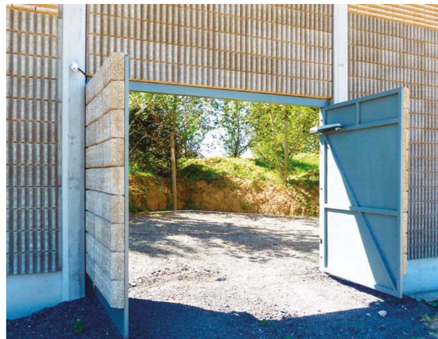
Verkleidung von Torauskragungen.
