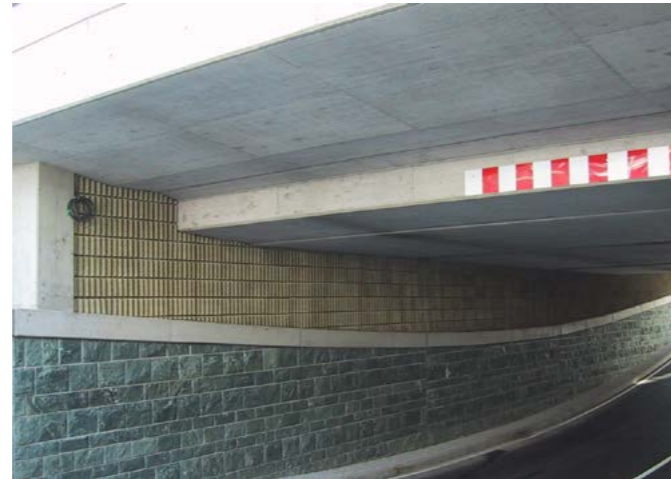
Verkleidung einer gewölbten Wand mit Leube Faseton® Elementen
