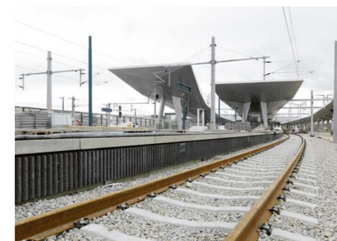
Hochabsorbierende Bahnsteigkante, Hauptbahnhof Wien, AT.
