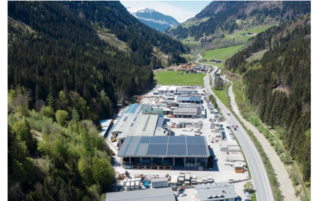
Leube Betonteilewerk in Maishofen, AT.
